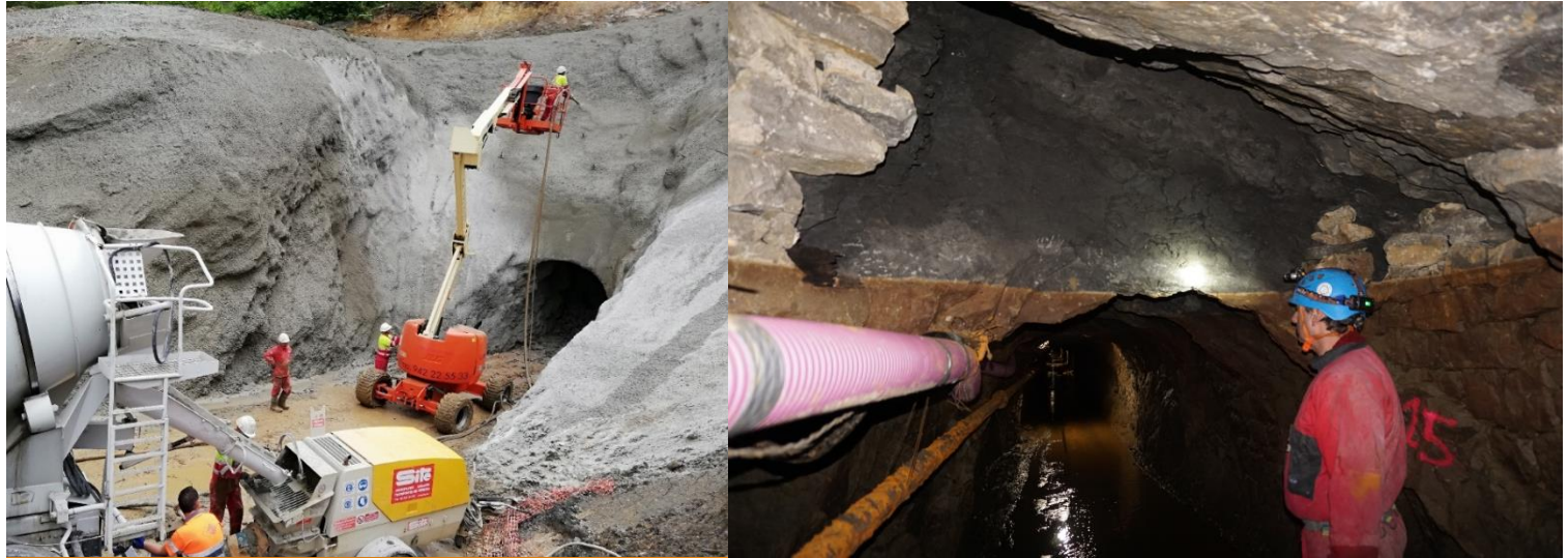
GALERÍA ANA. Minas de La Florida – El Soplao (Cantabria)
